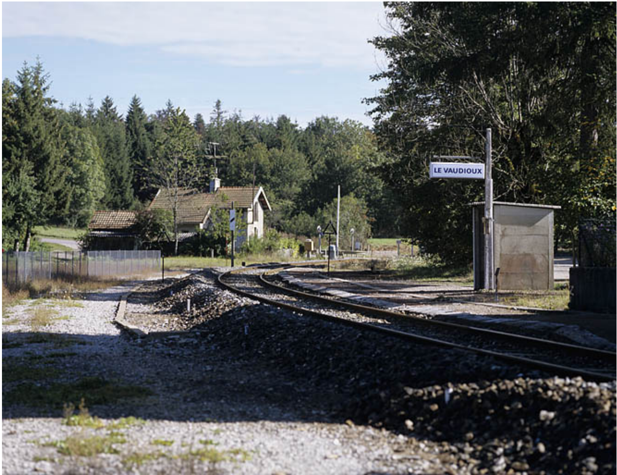
Quai des voyageurs et voie, vers le côté Andelot-en-Montagne.
