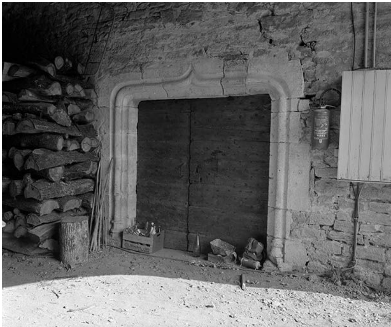
L'entrée du sous-sol sous le passage voûté.
