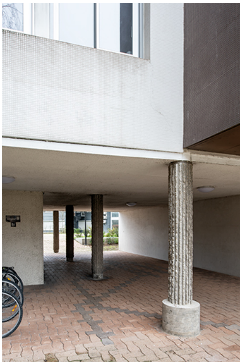
Passage en rez-de-chaussée.
