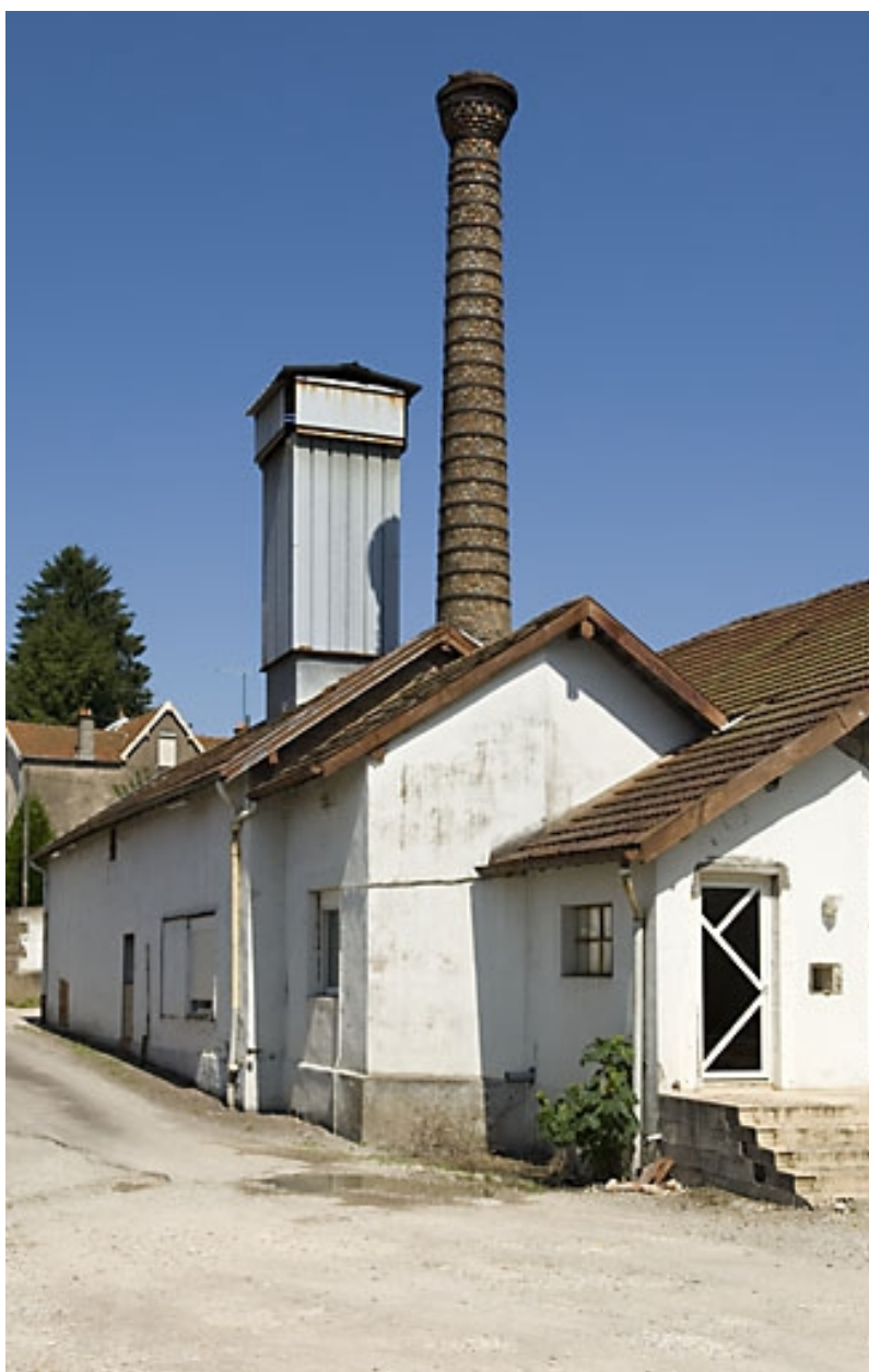
Atelier de fabrication et cheminées.
