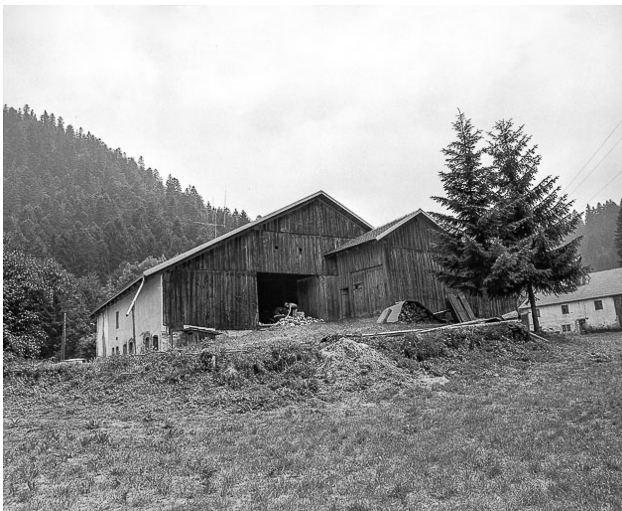
Façade ouest, en 1976.
