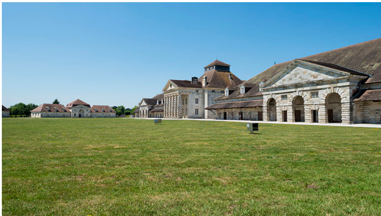
Vue d'ensemble depuis l'est de la cour.
