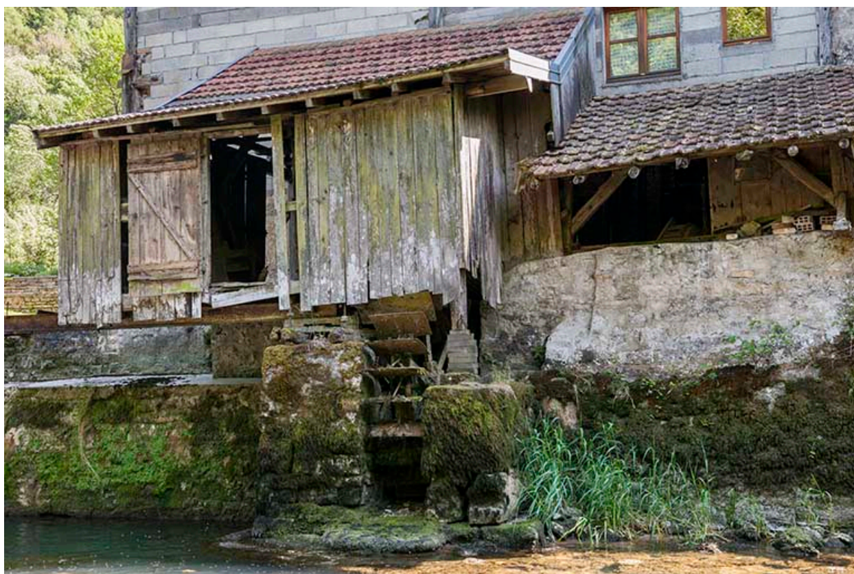
Façade nord. Le bâtiment d'eau.
