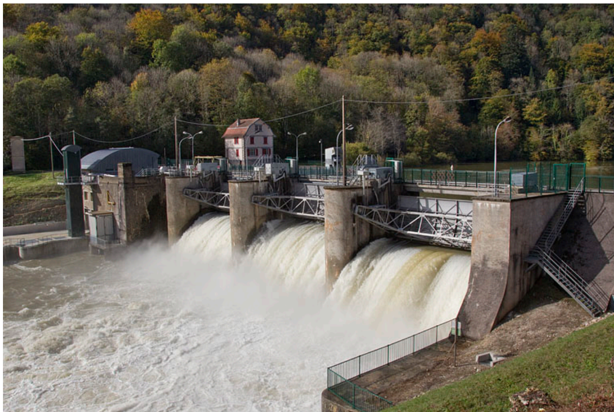
Barrage de Grosbois en période de crue, Soultz-Cernay.
