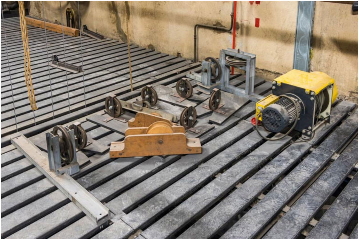
Cintre : moteur électrique et poulies.
