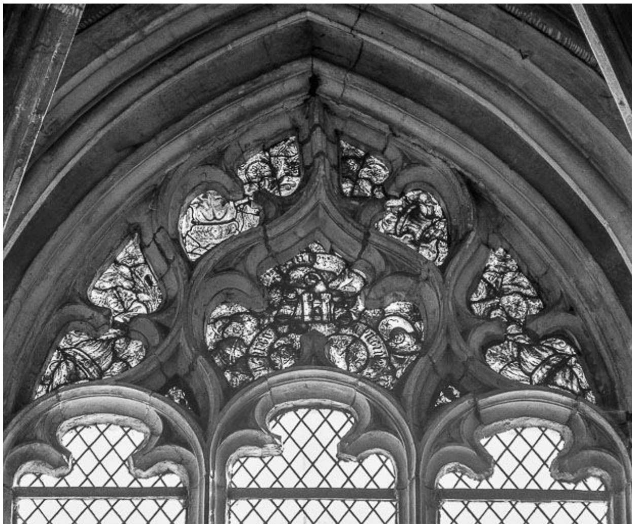
Tympan d'une des baies latérale.
