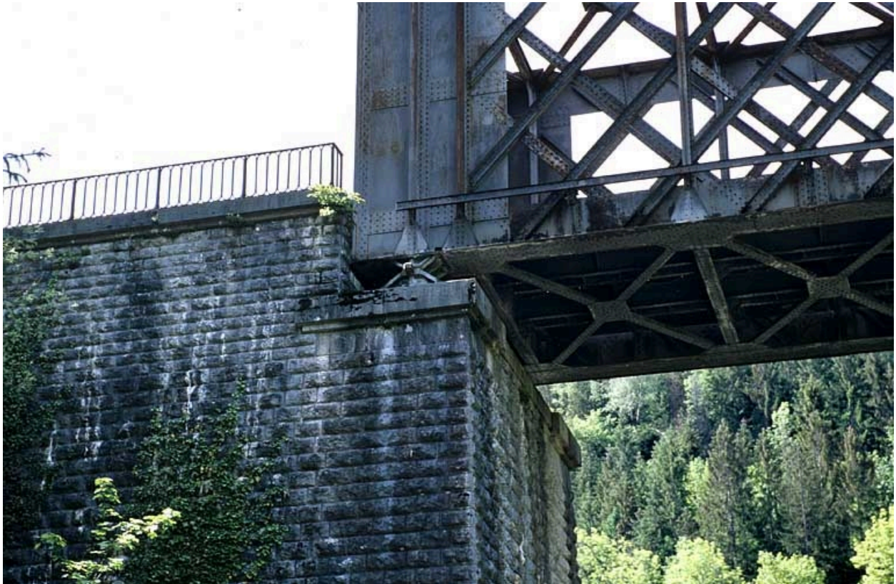
Extrémité côté La Cluse et culée, depuis l'amont : détail montrant l'appui fixe.
