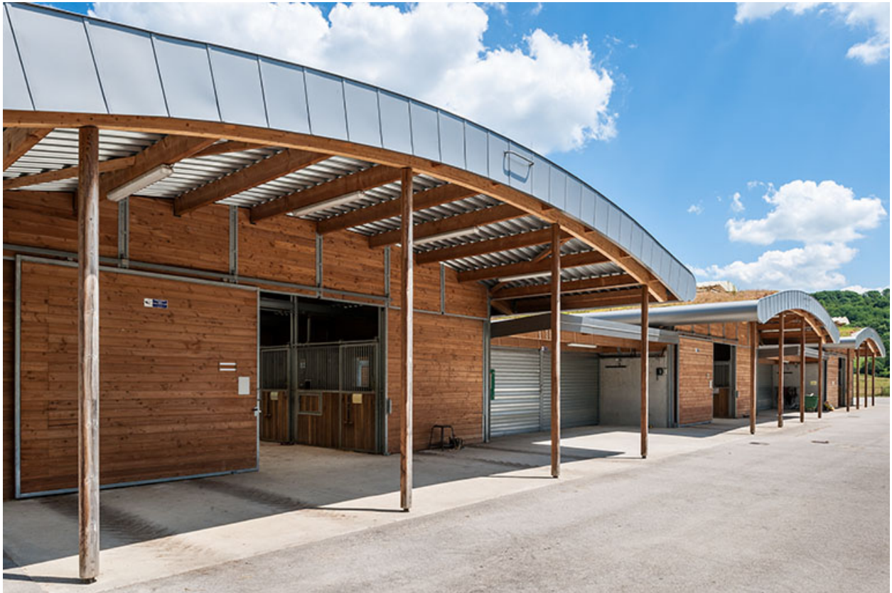
Centre équestre : façades des boxes d'enseignement.
