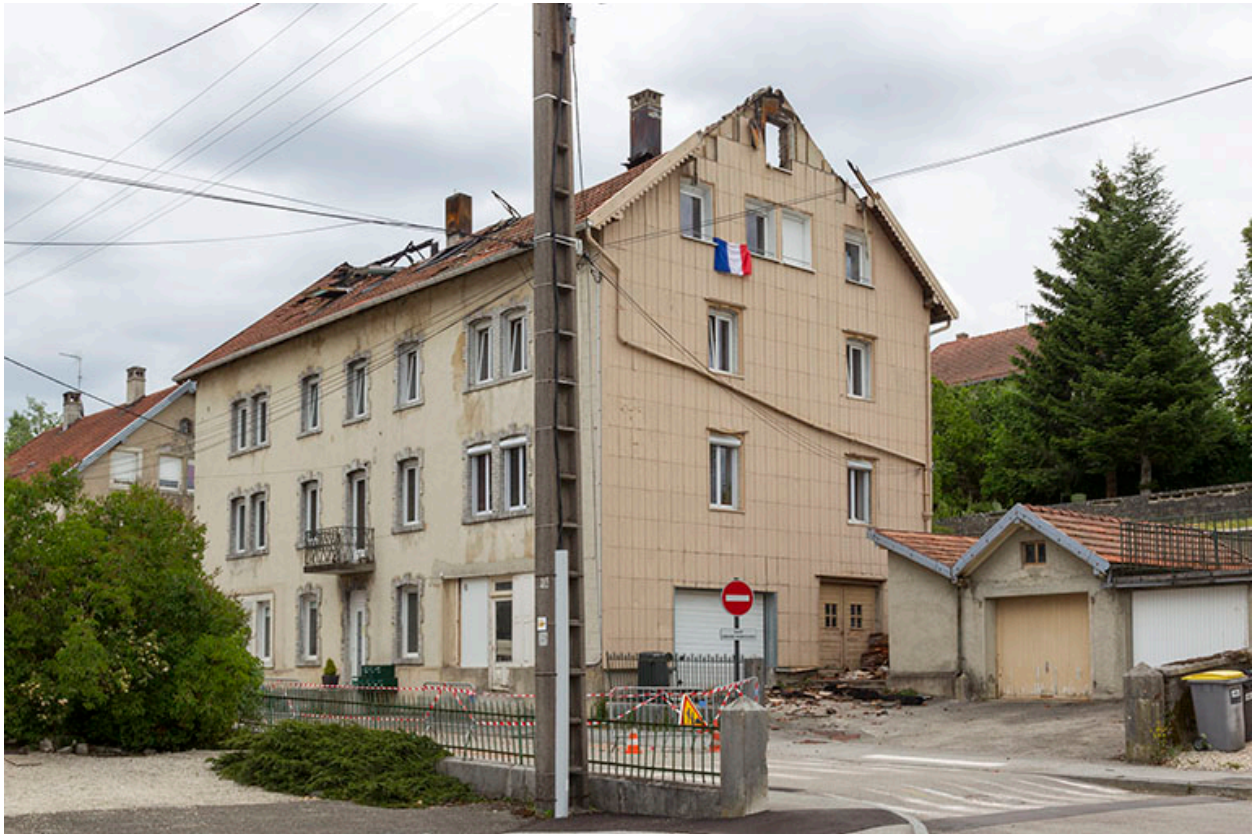
Vue d'ensemble, depuis l'ouest (façades antérieure et latérale droite).
