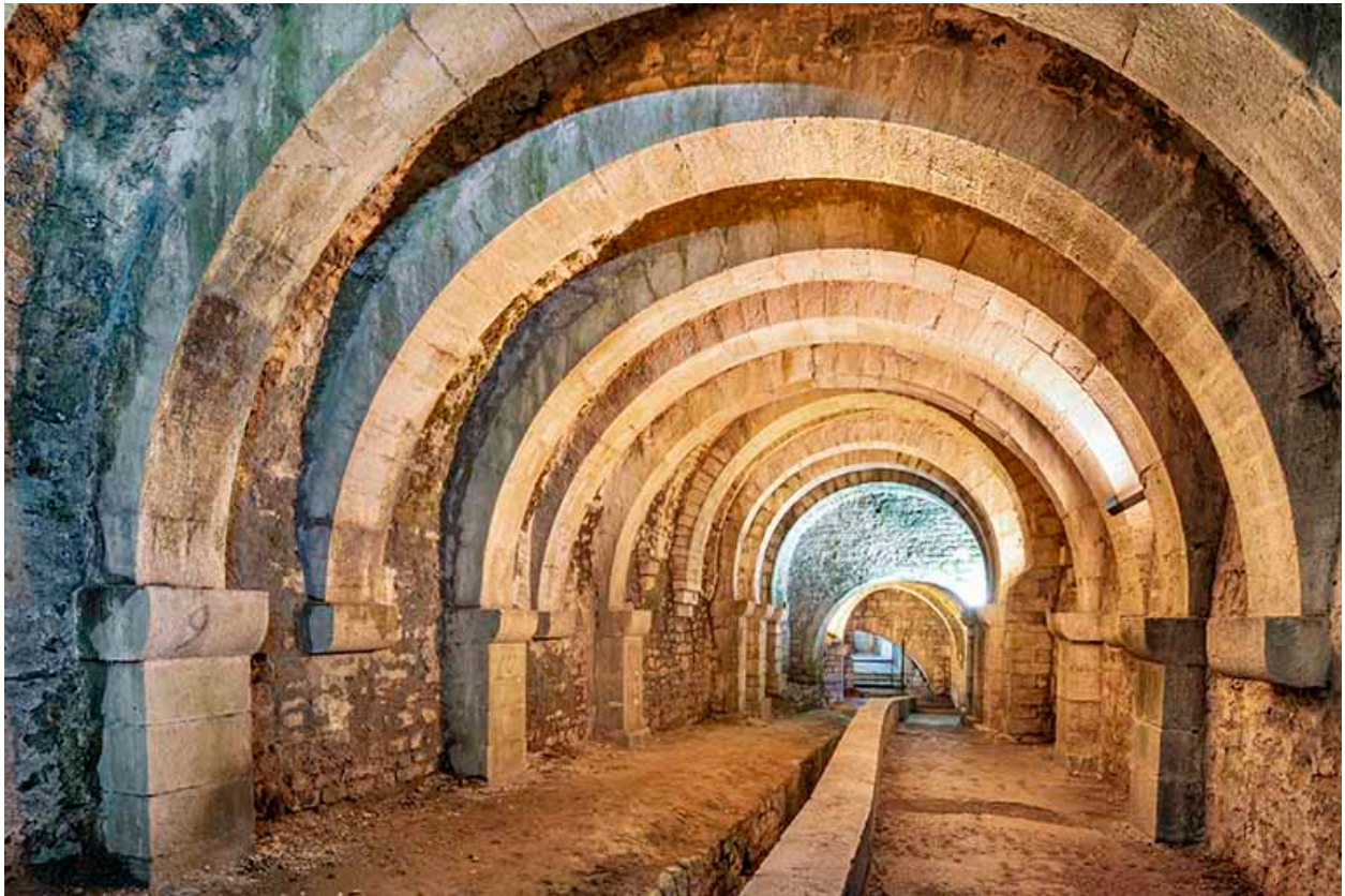
Partie nord de la galerie de communication entre les deux puits.
