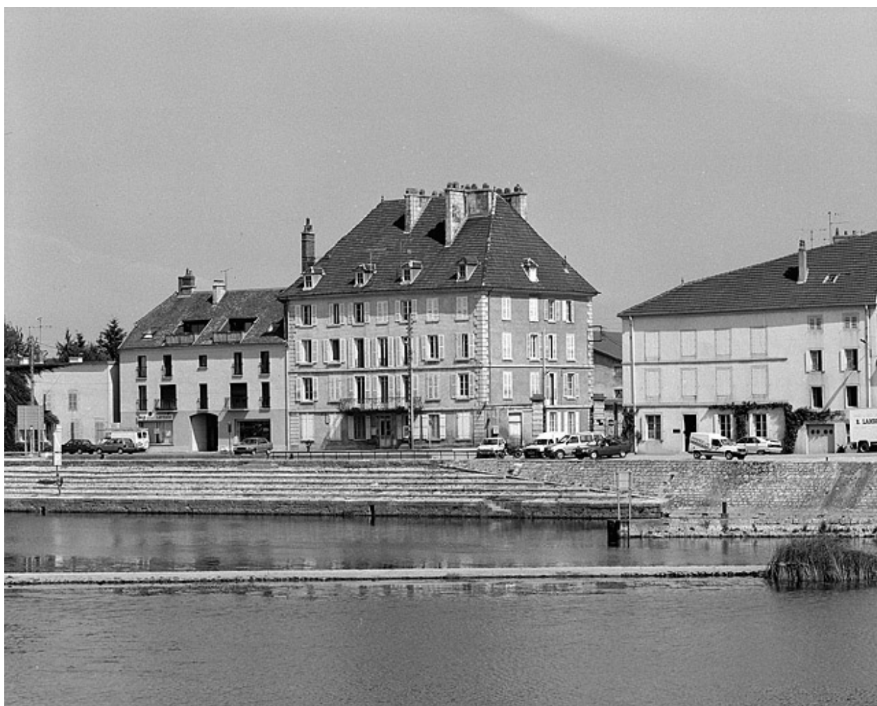
Maisons situées quai Villeneuve.
