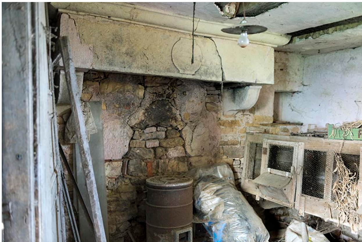
Cheminée au rez-de-chaussée du pigeonnier.
