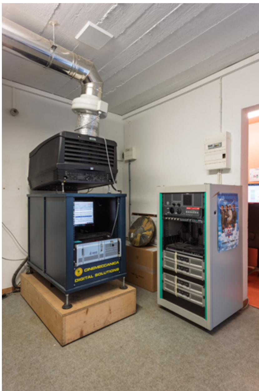
Cabine de projection : projecteur numérique Barco DP2K-15C.
