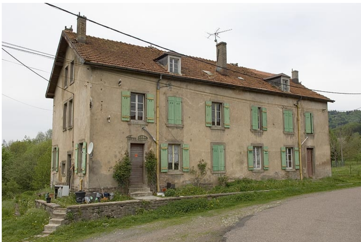
Logement ouvrier collectif.
