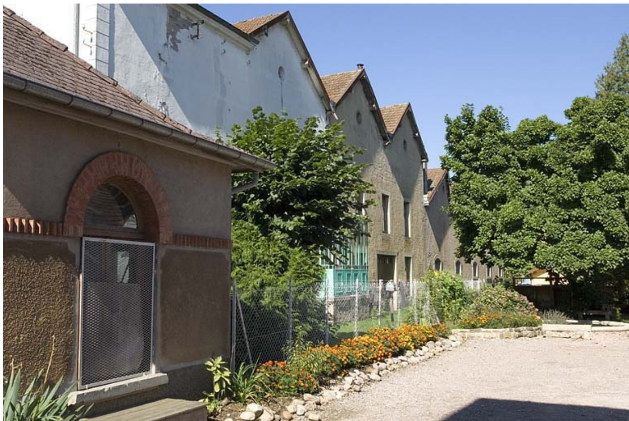
Façade postérieure de l'atelier de fabrication nord.
