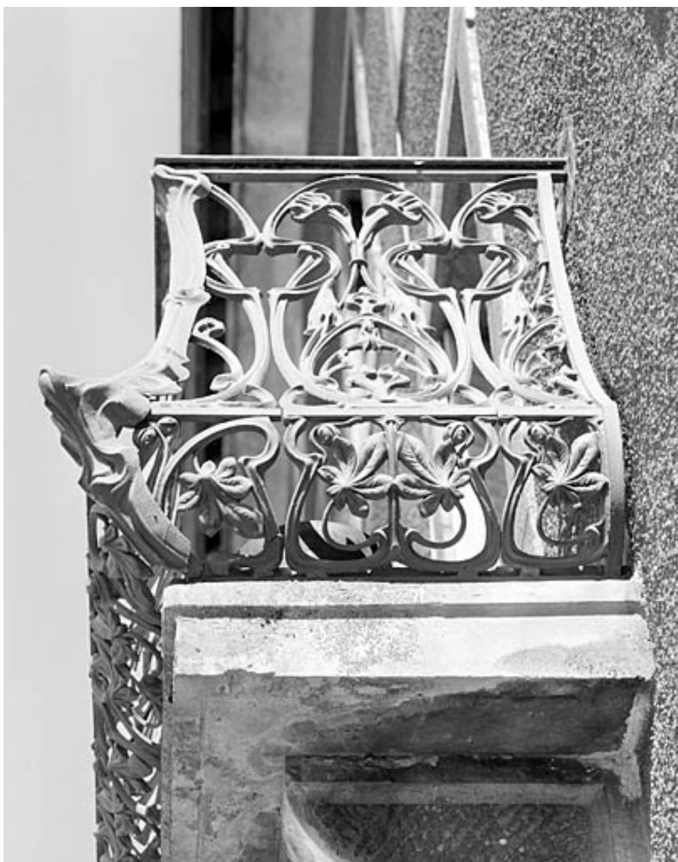
Balcon de l'immeuble : détail du garde-corps.
