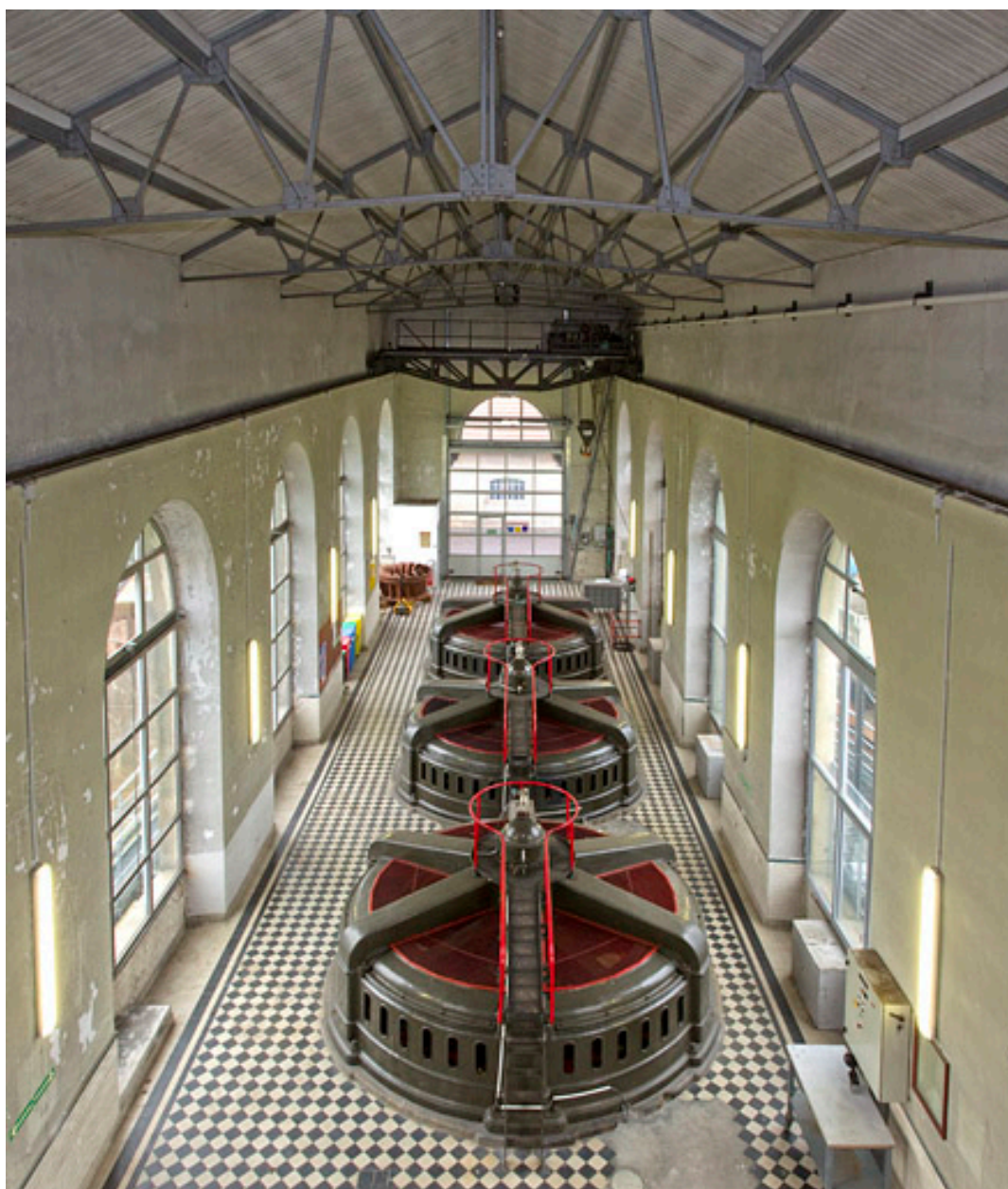
Salle des machines. Alignement des groupes turbo-alternateurs.
