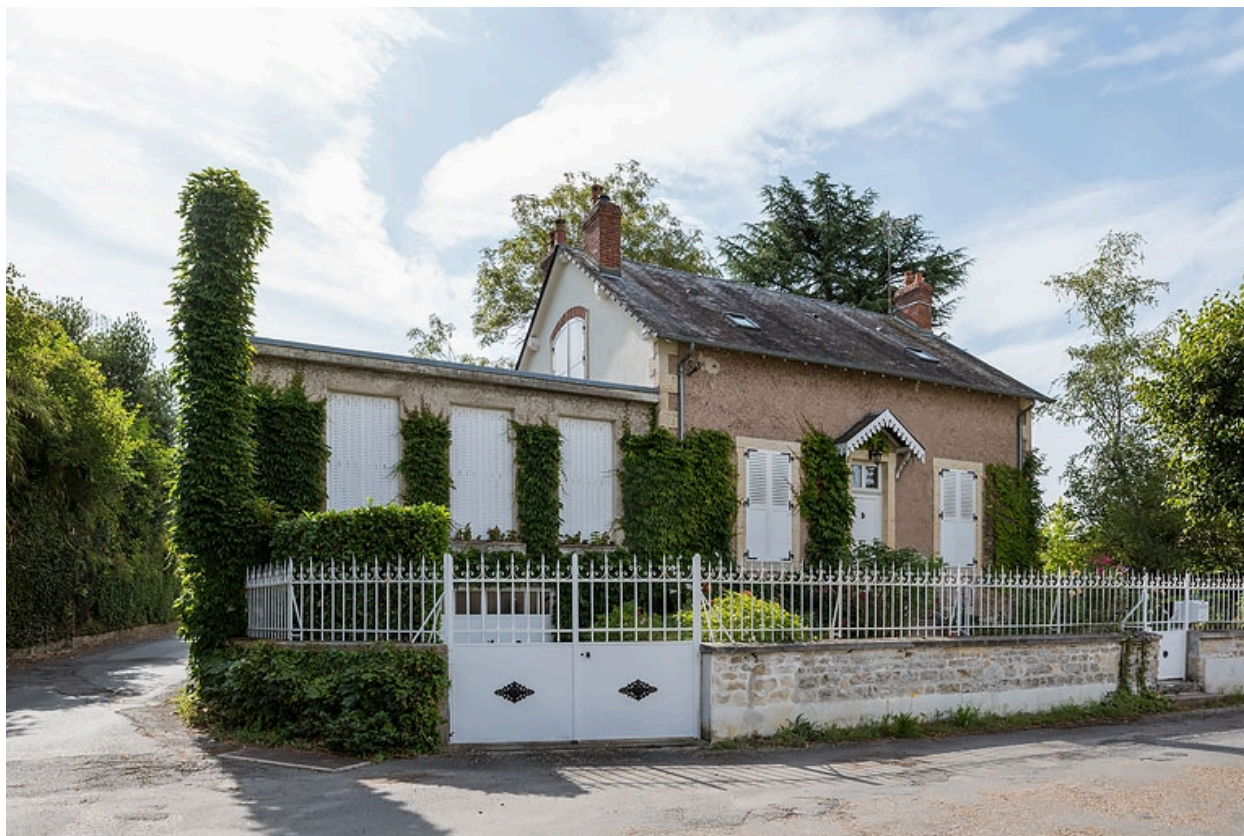
Vue de trois quarts depuis le nord.
