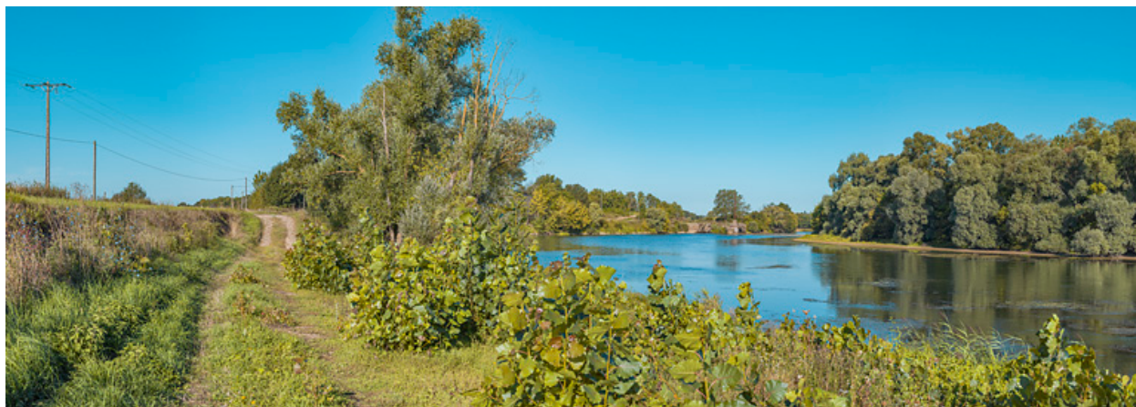
Vue d'ensemble du site du barrage en 2019.
