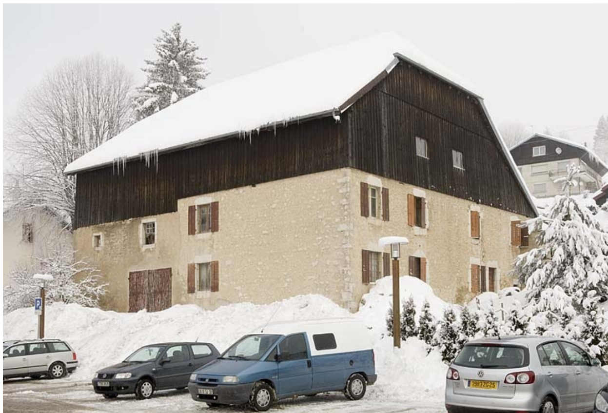
Façades postérieure et latérale gauche, en hiver.
