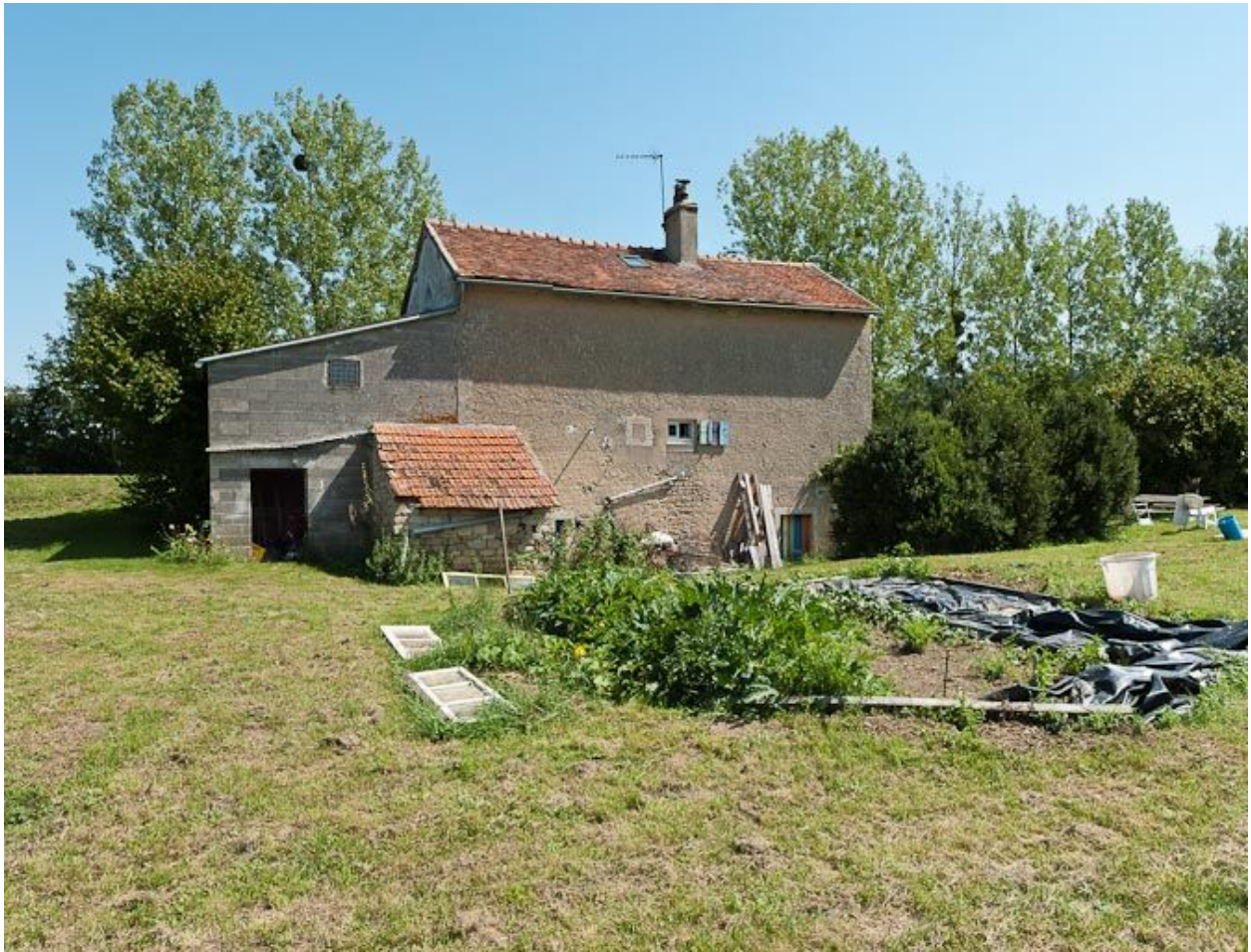
Vue arrière de la maison éclusière.
