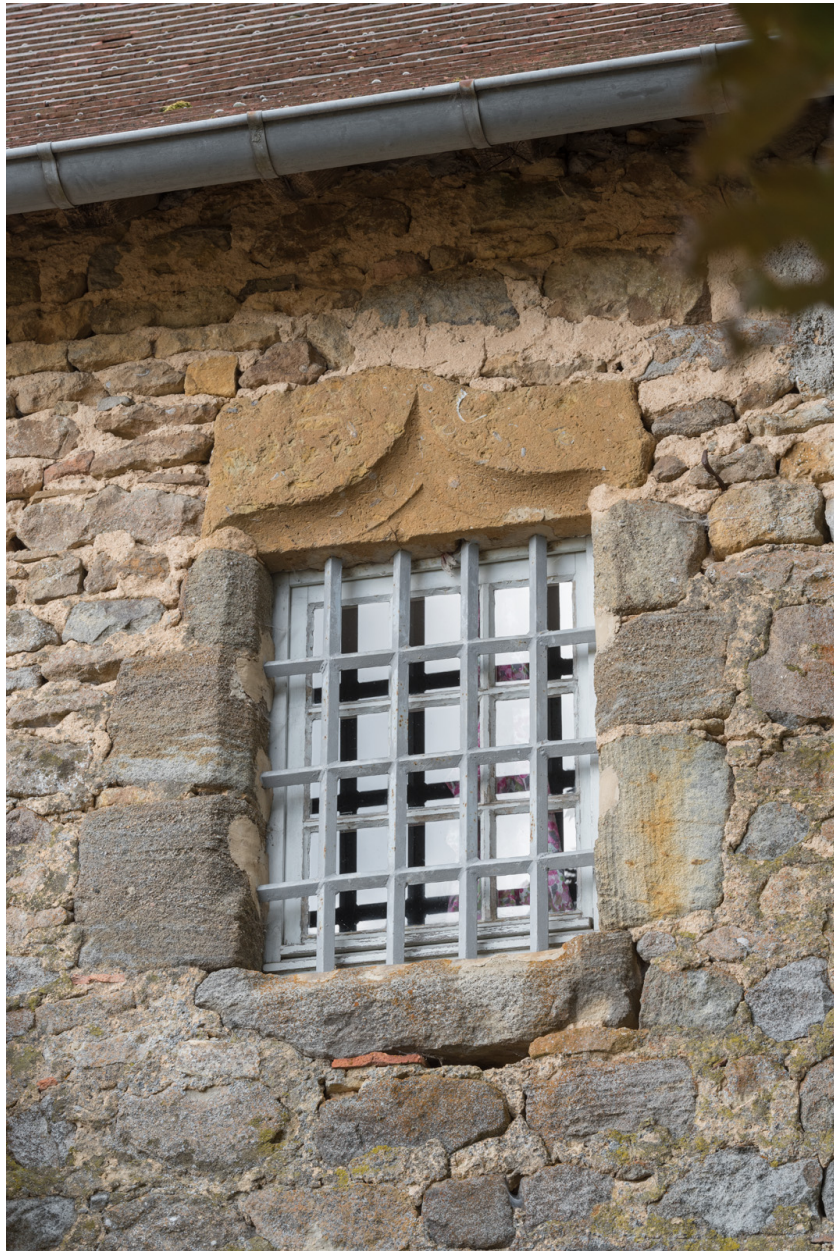
Détail de la baie ouest à l'étage de la façade postérieure.
