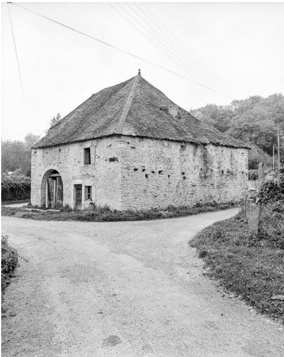
Façades antérieure et latérale droite.
