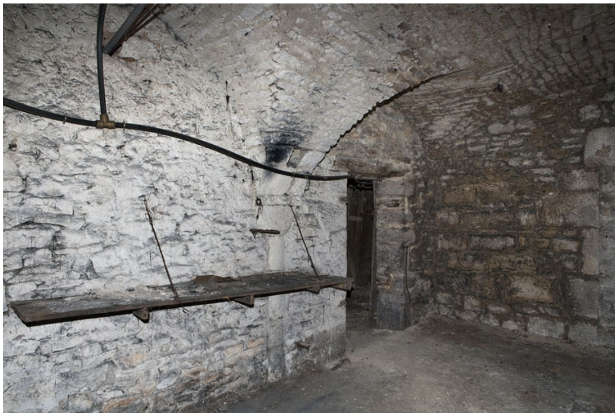
Logis principal, sous-sol : cave C.
