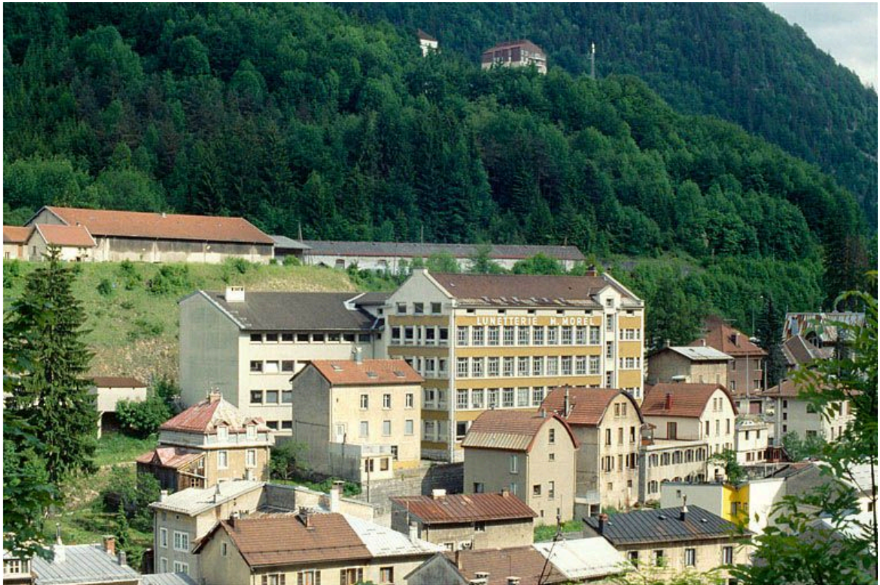
Vue d'ensemble de la façade postérieure.
