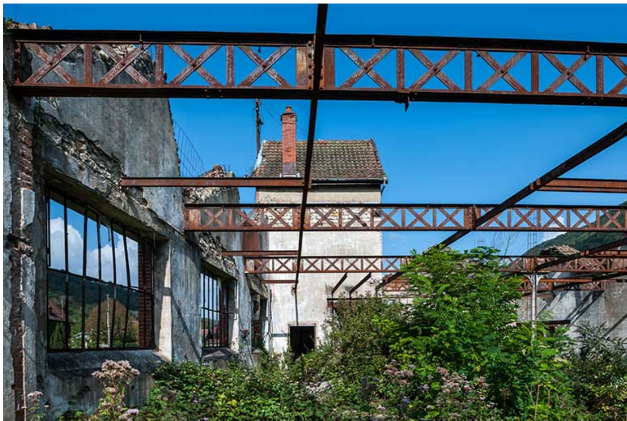
Intérieur de l'atelier de fabrication.
