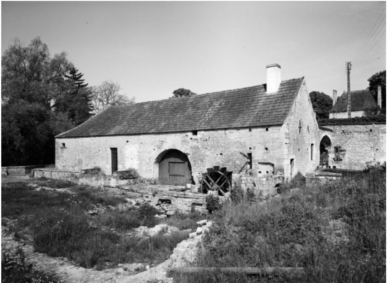
Bâtiment de la fenderie, élévation est.
