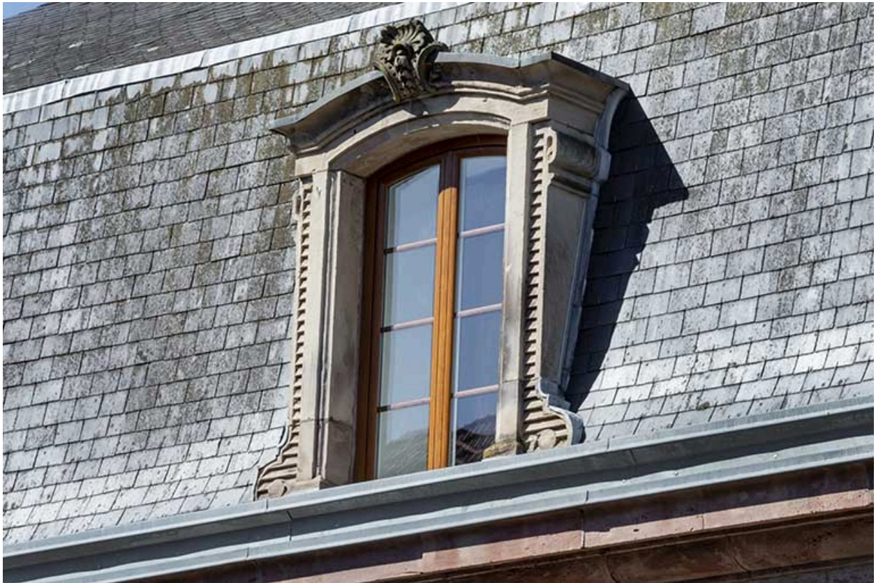
Maison Desgranges, lucarne est (lucarne centrale).
