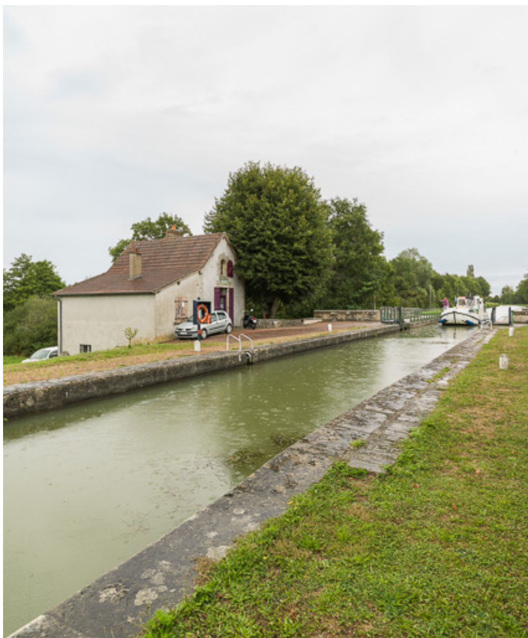
Vue du site et de la maison éclusière.
