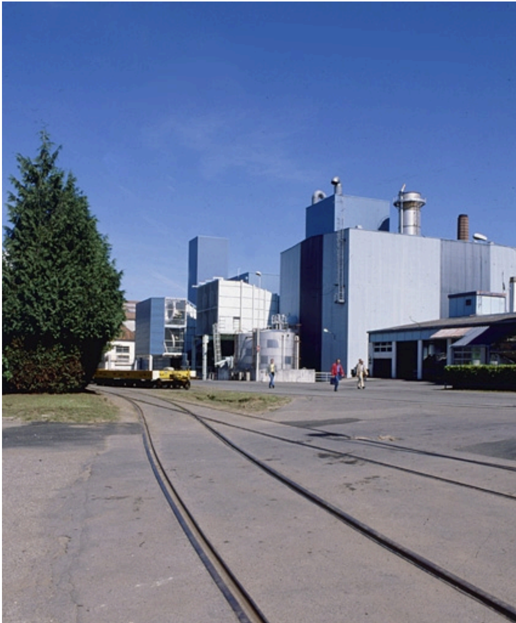
Ateliers de fabrication 53A et 57.
