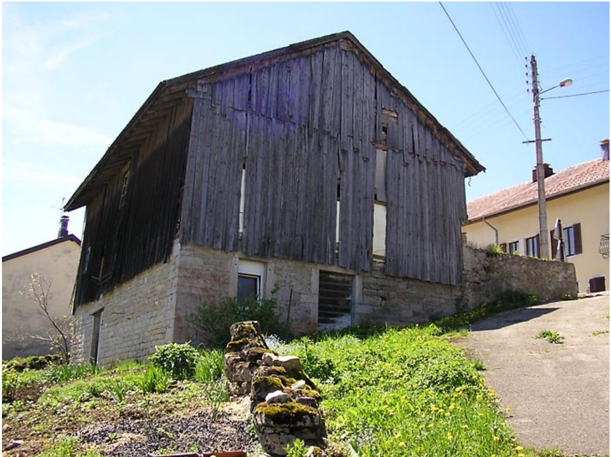
Pignon sud vu de trois quarts.
