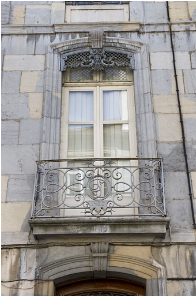
Logis principal, façade antérieure, premier étage : détail de la porte fenêtre.
