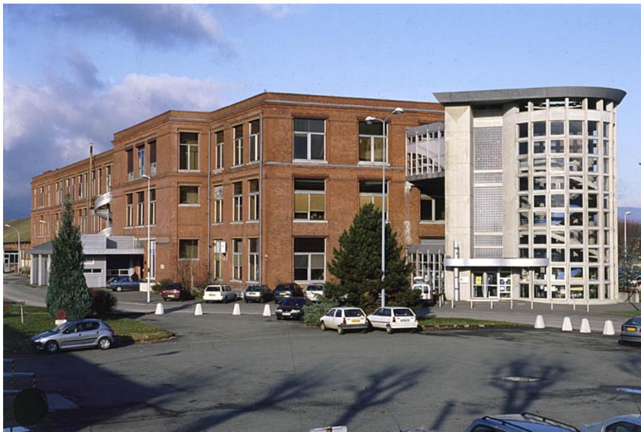
Extension de l'atelier de retordage : vue depuis le sud.
