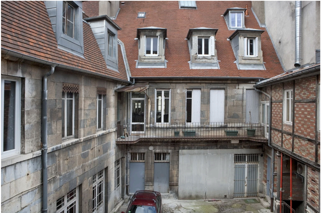
Vue d'ensemble de la façade postérieure du logis principal et d'une partie de l'aile droite.
