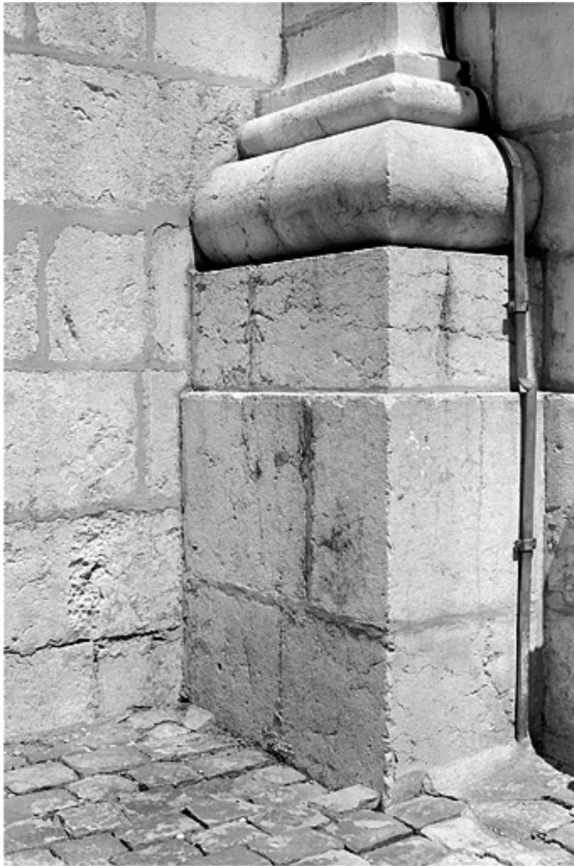
Détail de la façade occidentale.
