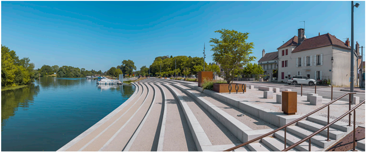
Vue d'ensemble des quais après leur réaménagement.
