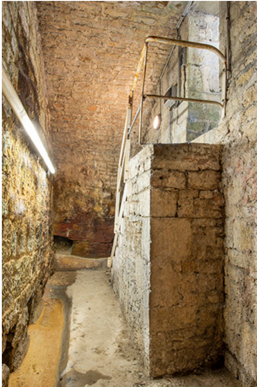
Pièce de captage des sources.
