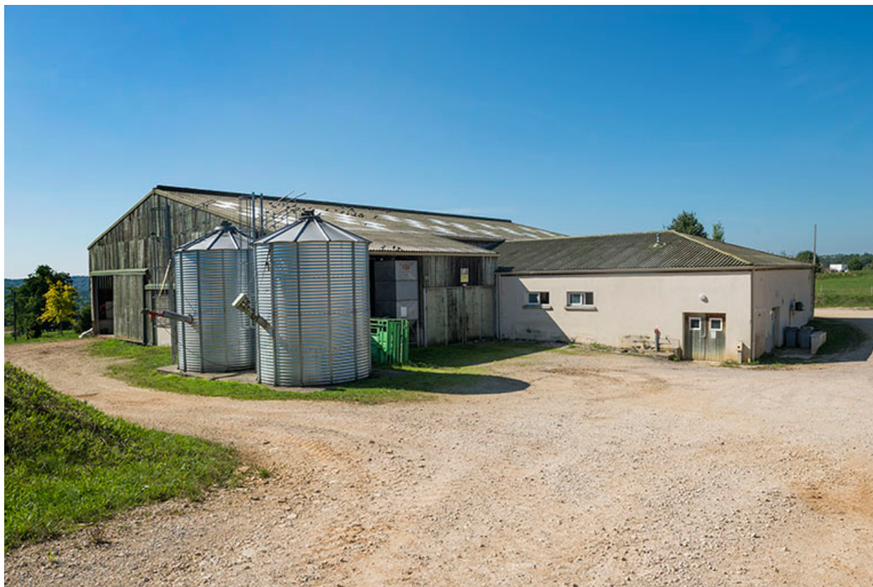
Façade est du bâtiment de production laitière.
