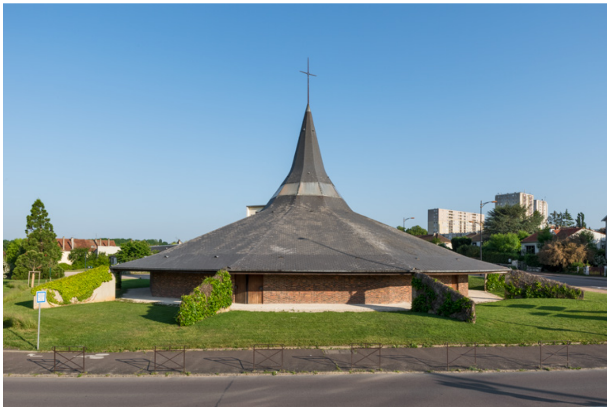
Vue depuis le sud-ouest.
