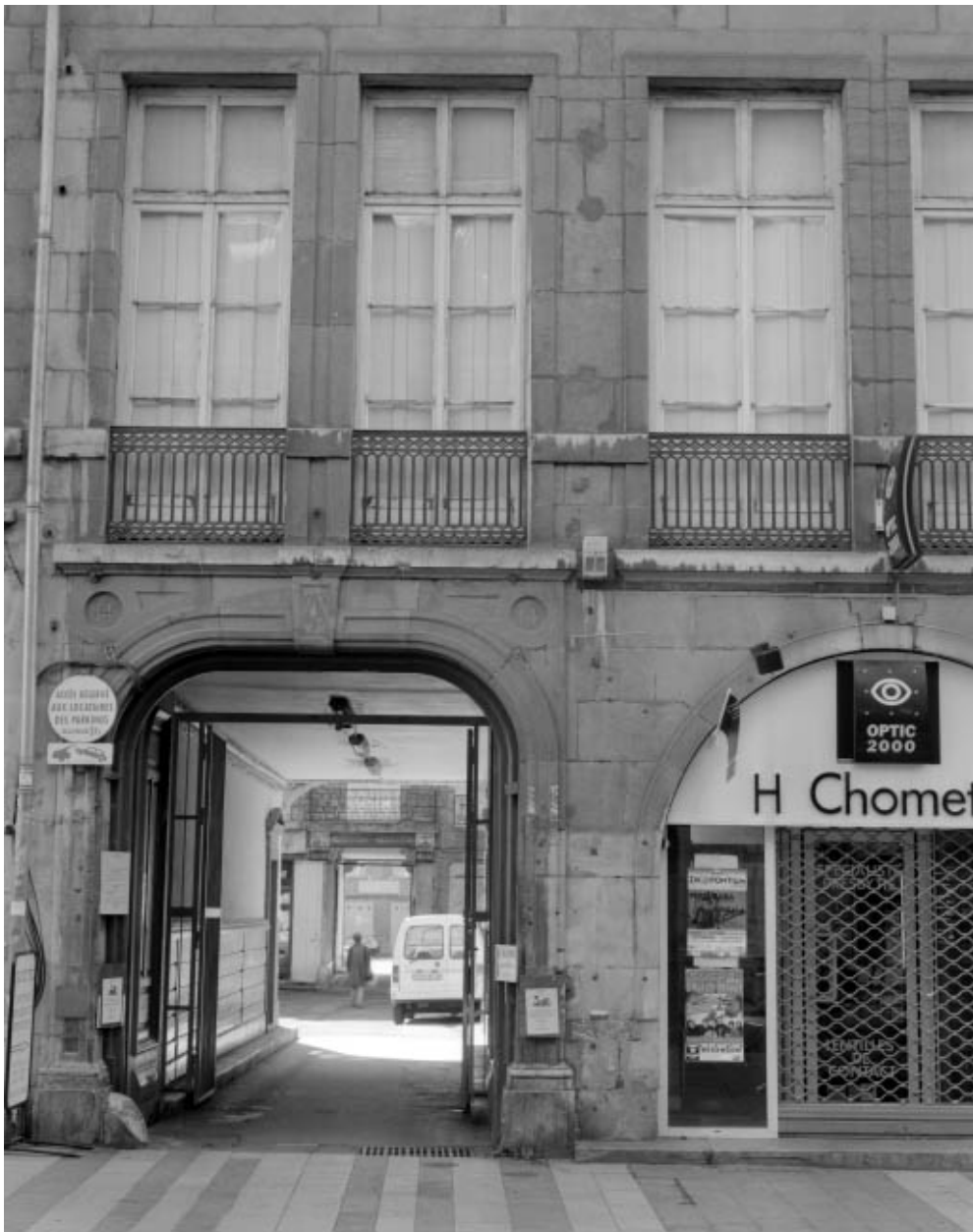
Façade sur rue, détail de l'entrée cochère.
