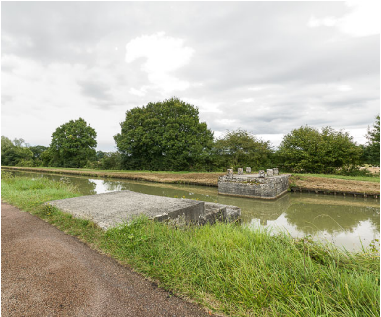
VUe des vestiges du pont.
