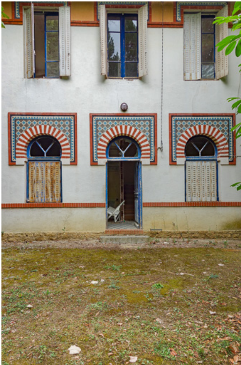
Élévation du pavillon du gardien, façade principale.
