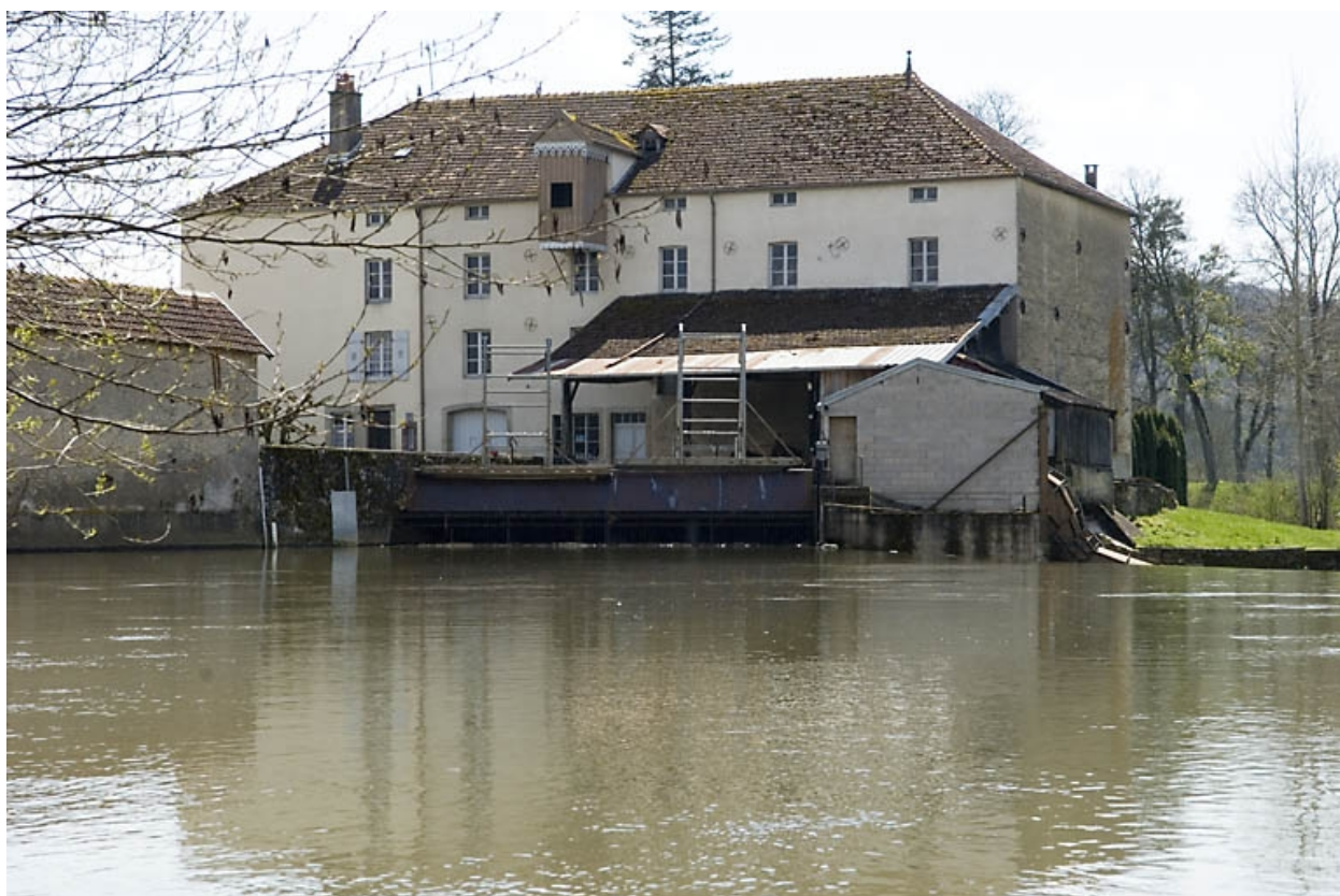
Façade antérieure depuis l'amont.
