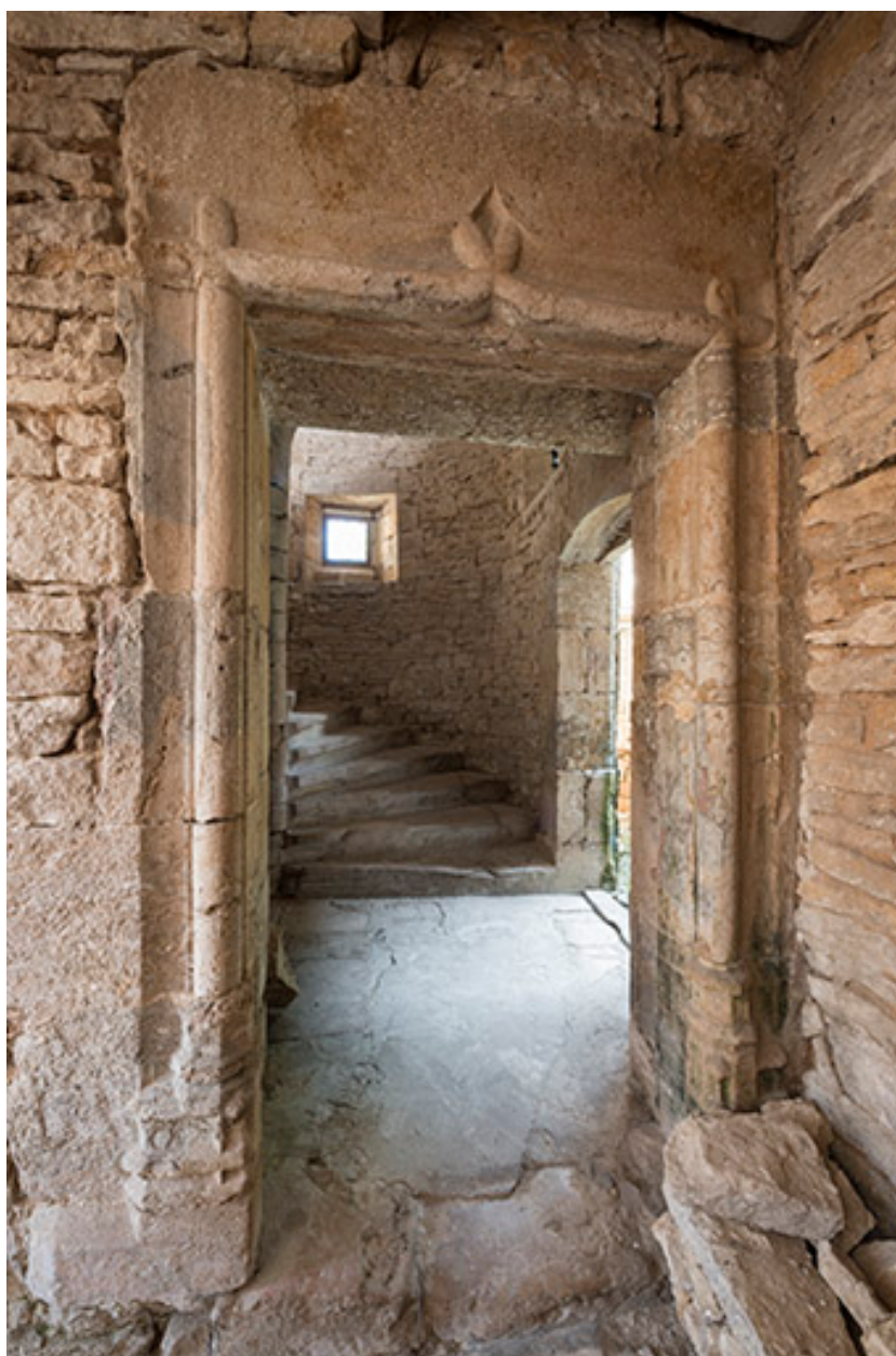
La porte d'accès à la tour, rez-de-chaussée.
