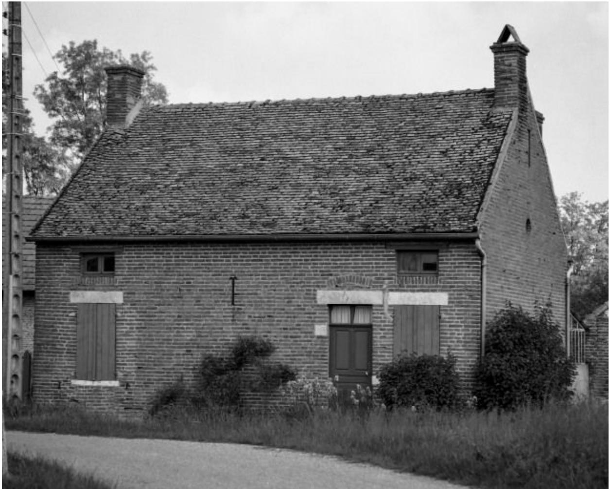
Vue d'ensemble d'une ferme (cad. 1981, sect. B2, parc. 555).
