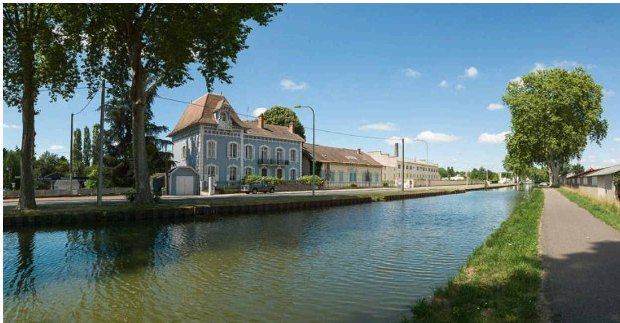
Les bâtiments de l'usine, rive gauche.
